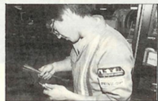
②次にシャシーダイナモにより負荷をかける。すると点火電圧が高いのでこれは燃料が薄いと判断。追加インジェクター・レビックの噴射タイミングと量を変更し、理想の点火電圧にセッティングした。
